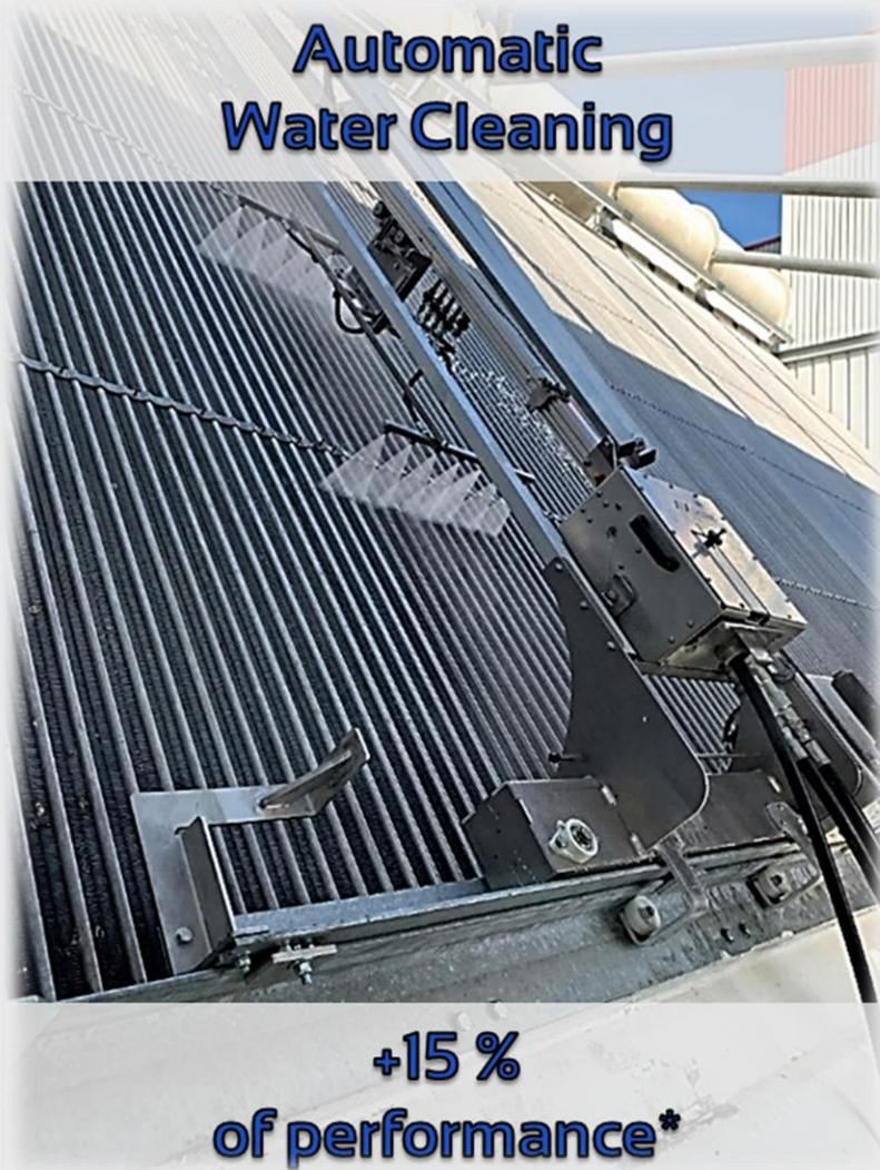
Grâce à notre expérience sur ACC/ACHE, nous avons conçu une solution de nettoyage pour gagner du temps :
